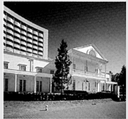
19世紀アメリカ南部の建築様式によるジョージアンテラスは、映画「風と共に去りぬ」のシーンをイメージさせる造りだ
