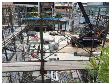
基礎工事が完了し足場の組み立てが始まりました。
